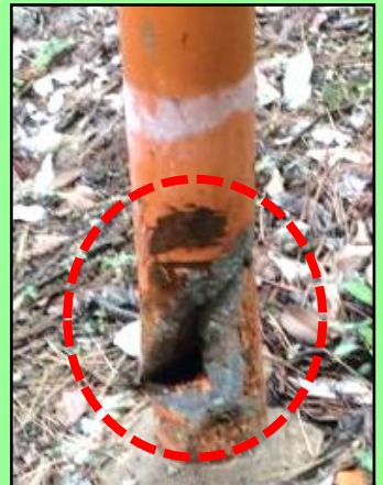
柱がさびて 穴が開いている
