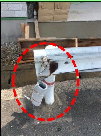
ガードレールが 破損している
